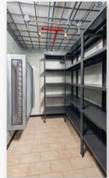
Internal view // Vista interna
