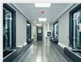
Internal view // Vista interna
